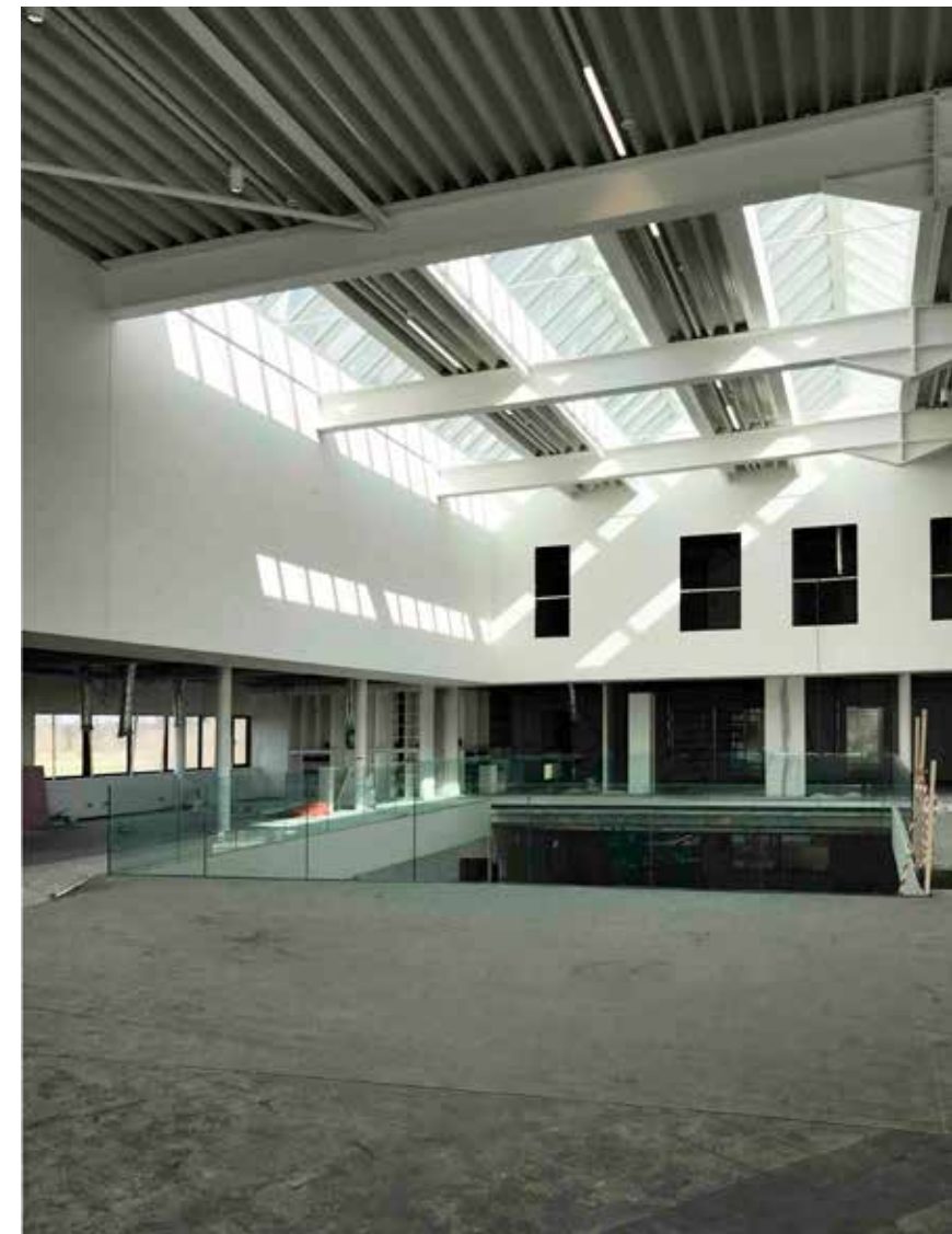
Het aanbrengen van de drie lichtstraten was niet eenvoudig. "De toleranties op de staalstructuur bedroegen slechts enkele millimeters," zegt Dries Van Hamme.
